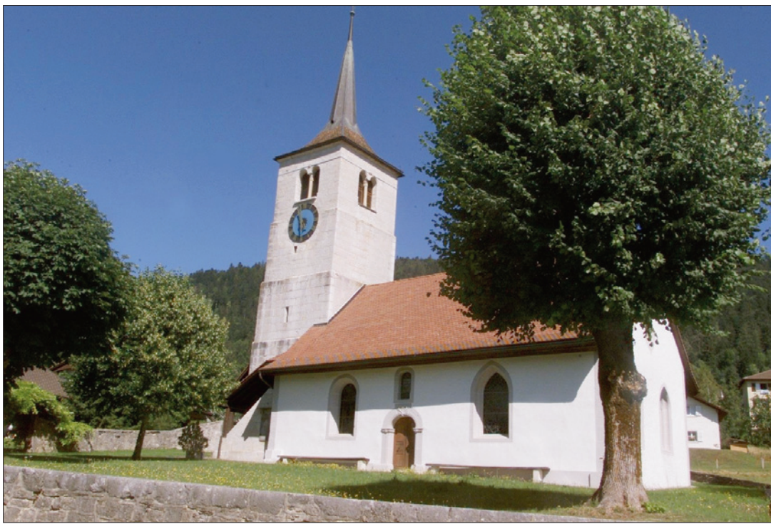
PAROISSES Elles comprennent depuis belle lurette plusieurs temples chacune. (ici Chézard-Saint-Martin).
